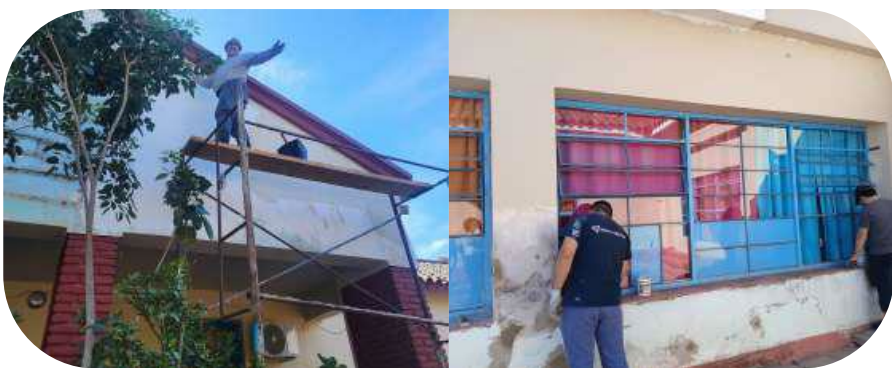
Trabajo en altura. Trabajando en el patio.
