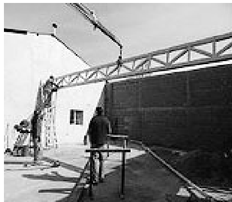
COLOCACIÓN DE VIGA METÁLICA Y COLUMNAS
