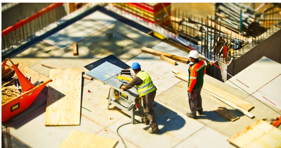
Hombres que trabajan en la construcción.
